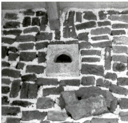
Muurdetail Foto: Ingrid Clemens
