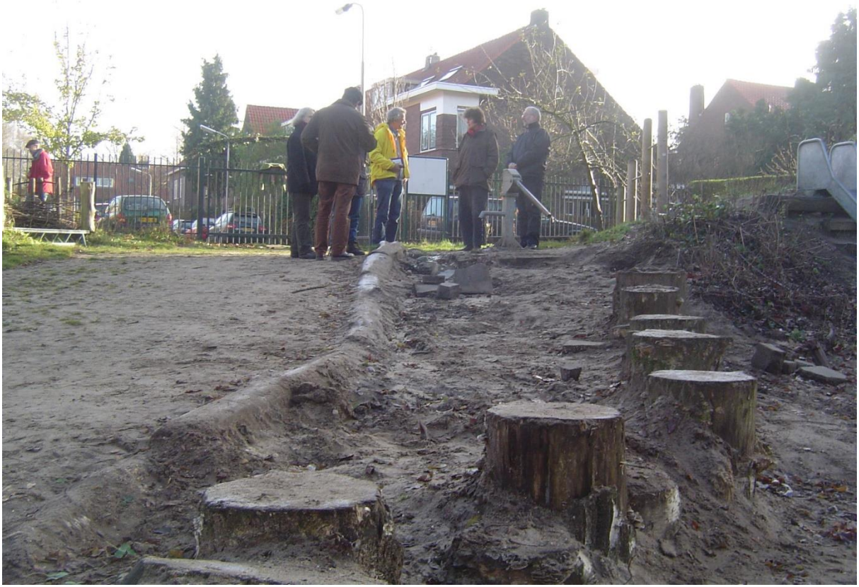
Een speelbeek met pomp in aanbouw
