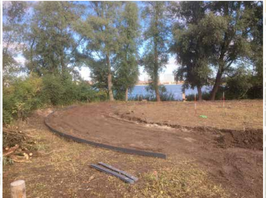
De eerste contouren van de aanleg met op de achtergrond het Weerwater en Almere-stad.
