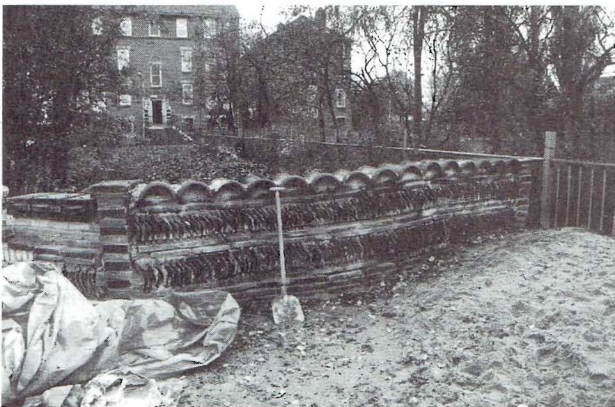
Ritmisch gestapelde keermuren bij Een Slingertouw in Nijmegen Foto: M. van Lier
