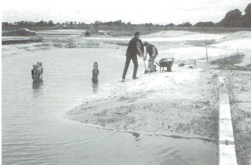
Foto 2. De aanleg van de Oosttuin is nagenoeg gereed, begin juli 1998. De mergel (witte plekken) wordt gradiëntsgewijs aangebracht en de donkere plekken op de heuvels rechts betreffen aangebrachte klei. De betonnen damwand (met daarin een overloop) op de voorgrond dient om de waterstand in de vijver op peil te houden.
