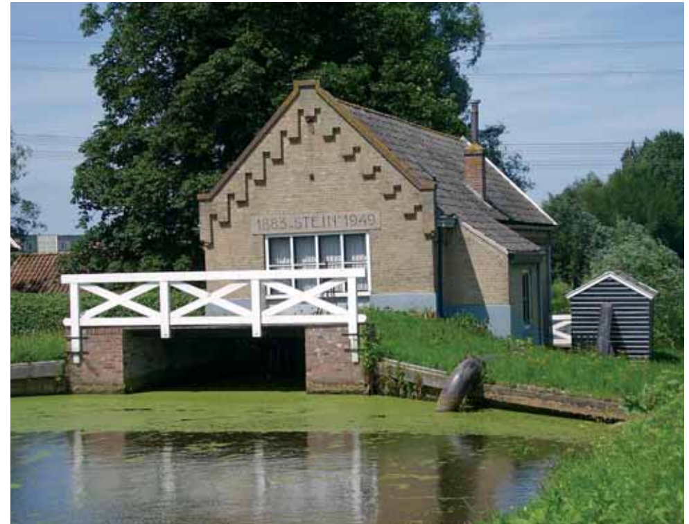
Het gemaal Stein.
